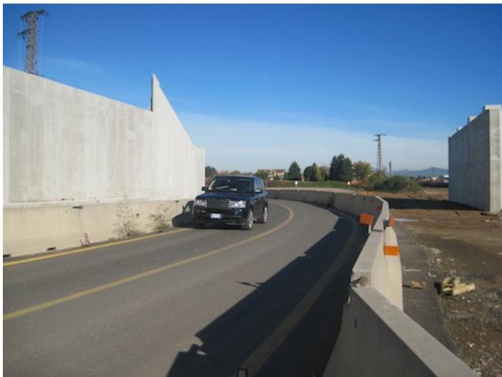
Non ci sono più solo chilometri di recinzione arancione. Sono sorti anche diversi “muri”, opere che sosterranno le rampe di accelerazione e decelerazione dello svincolo autostradale **Uboldo-Origgio**. I diversi cantieri dell’ampliamento della terza corsia dell’autostrada A9, di cui il grande svincolo a semi-quadrifoglio fa parte, procedono velocemente.
