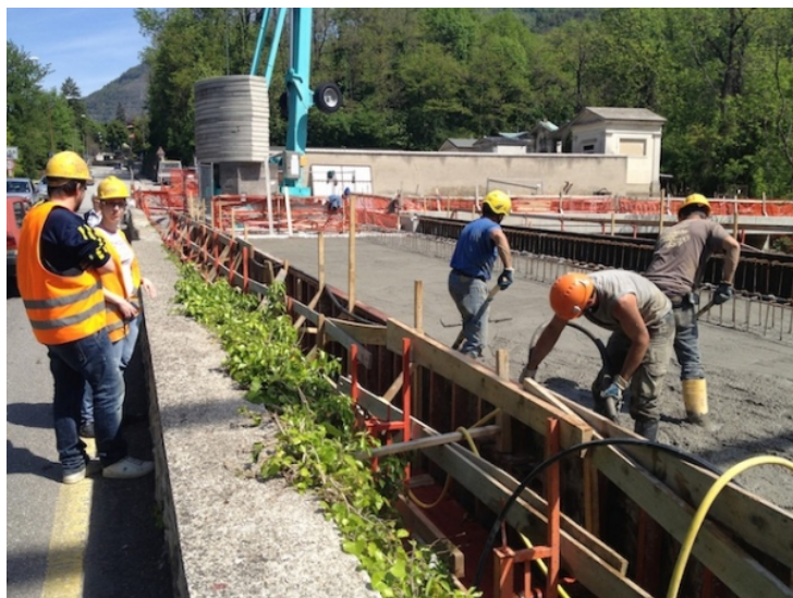
Proseguono i lavori al Ponte della Rasa.
