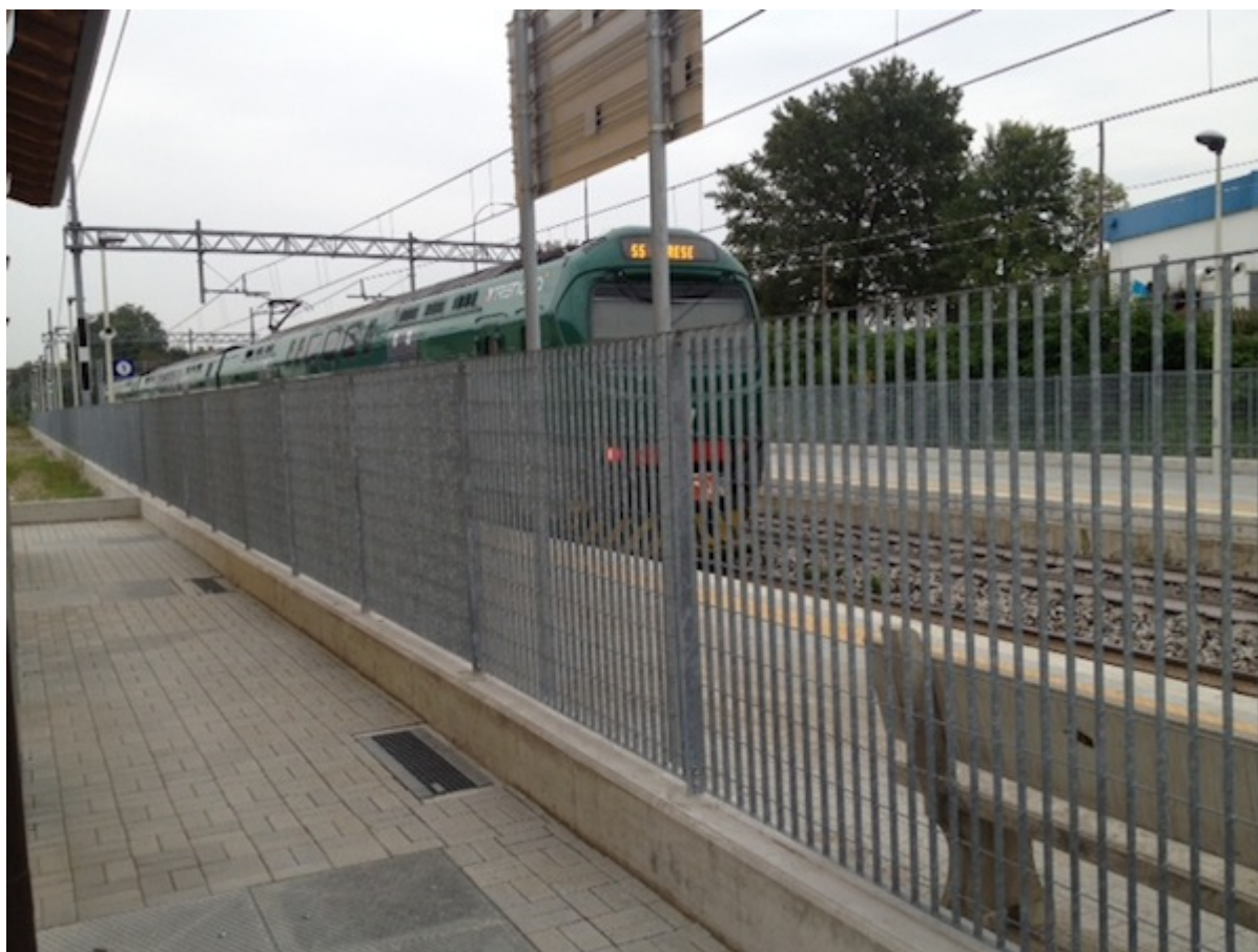
L'edificio della stazione
